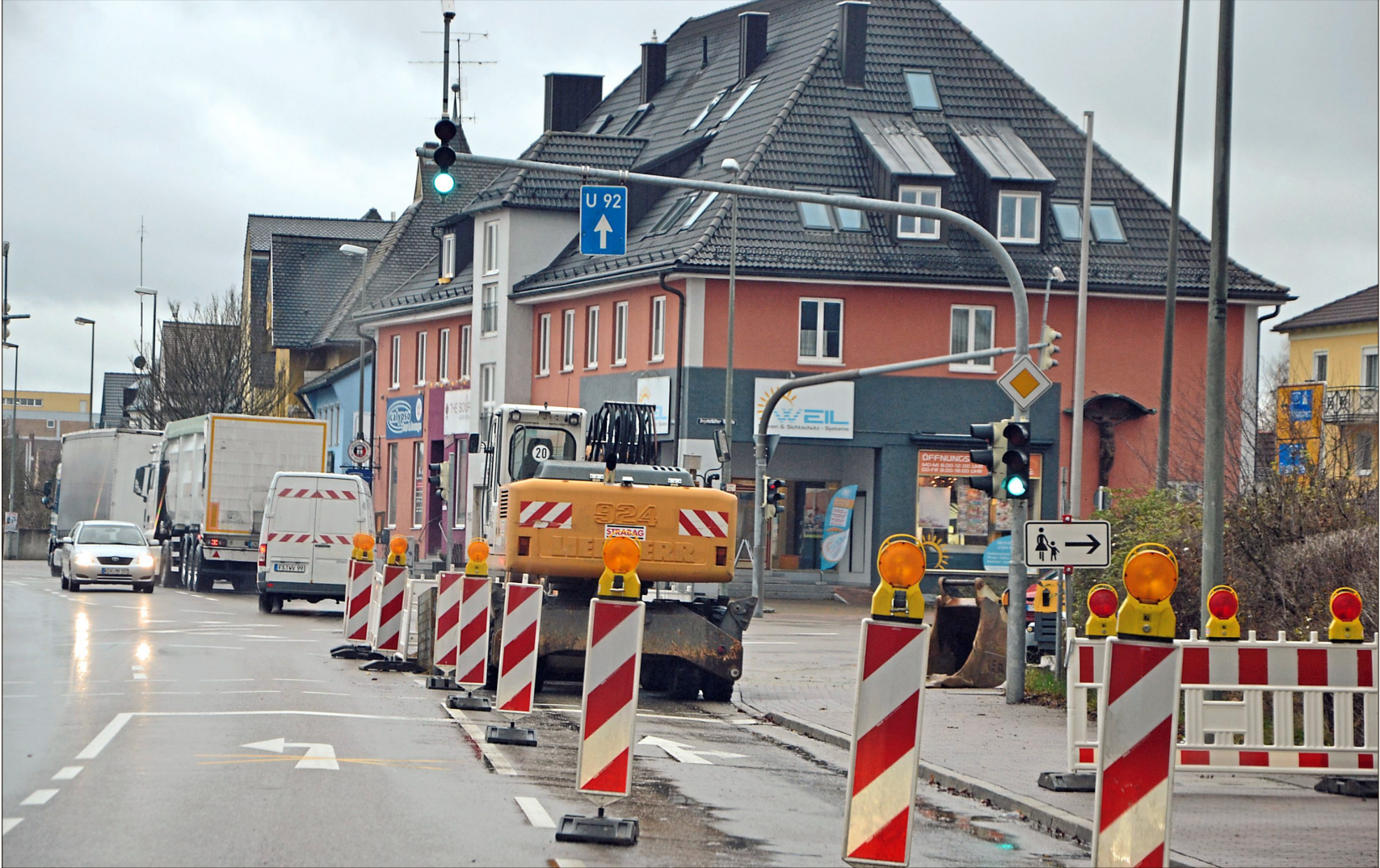
NOCH IN DIESER WOCHE FÜR DEN VERKEHR FREIGEgeben werden kann die einseitig gesperrte Regensburger Straße in Mainburg. Jedenfalls ist man im Stadtbauamt diesbezüglich bester Dinge. Die monatelangen Kanalbauarbeiten sind so gut wie abgeschlossen, es wurden zuletzt Restarbeiten an der ebenfalls neu verlegten Wasserleitung im Baustellenbereich sowie die Öffnung des verschlossenen Kanalstrangs an der Bahnhofskreuzung (unser Bild) durchgeführt. Nachdem auch die Asphaltierung erledigt ist, muss nur noch die Fahrbahnmarkierung aufgetragen werden. Foto: Kistler
